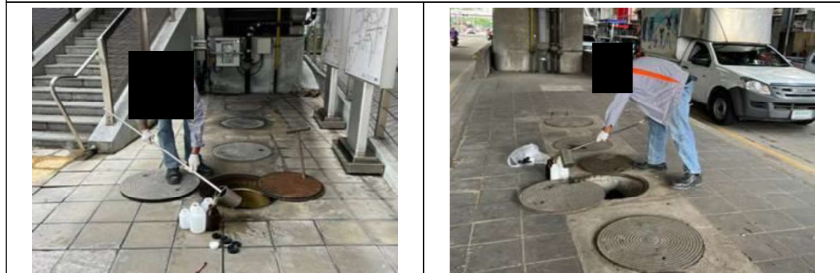
รูปที่ 2-10 การตรวจสอบและดูแลประสิทธิภาพการทำงานของระบบบำบัดน้ำเสีย ประจำสถานีรถไฟฟ้าอย่างสม่ำเสมอ
